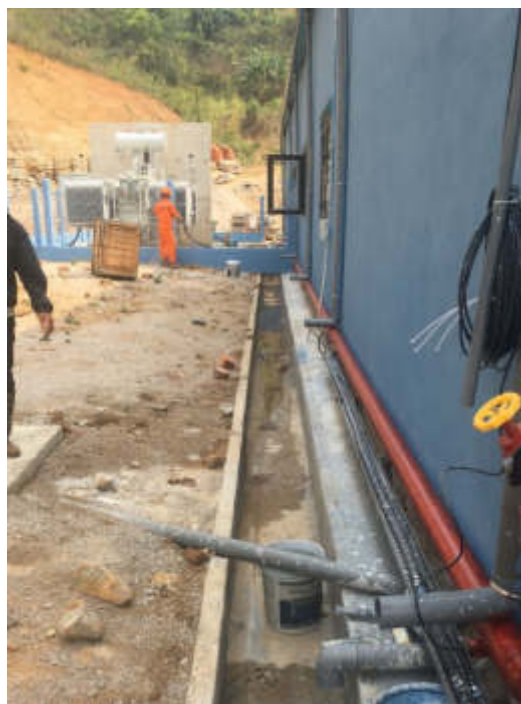
Ống dẫn nước mái và mương thu nước
